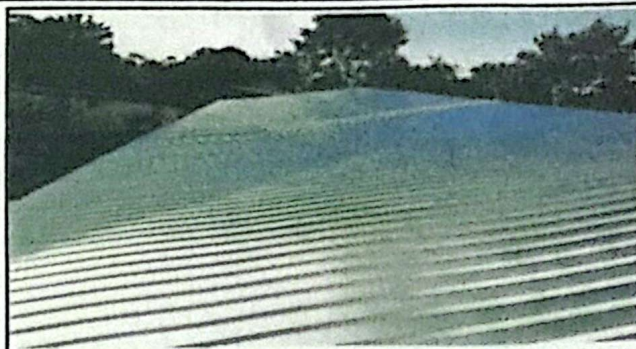
Foto 2: Sustitucion de techo completado del modulo 2.
