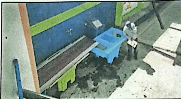
Foto 4: Sustitucion de 1 pila de dos lavaderos en el patio del establecimiento.
