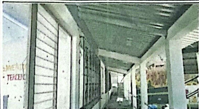
Foto 1: Sustitución de lamina troquelada aluzin calibre 26 en pasillo del modulo del establecimiento.
