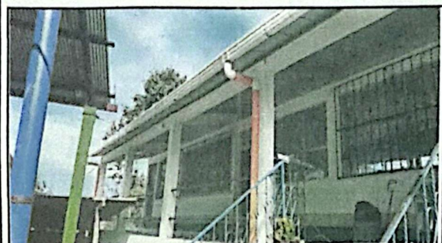
Foto 3: Sustitucion de Canales y bajadas de agua pluvial frente al establecimiento.
